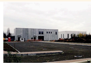
I lavori in area del nuovo parcheggio
